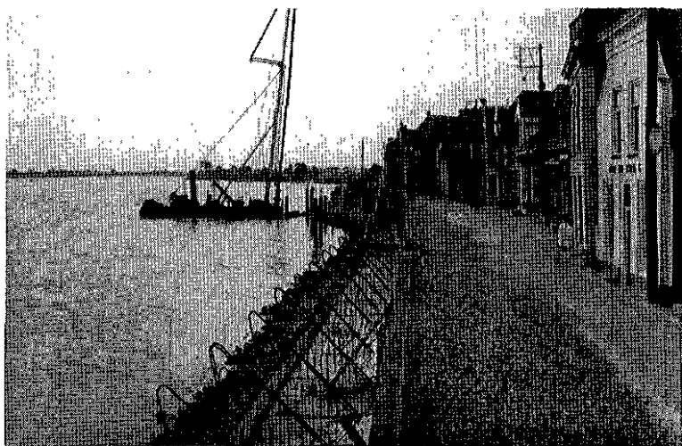
De nieuwe dijkmuur langs de rivier te Lekkerkerk in uitvoering
