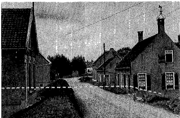
Eerste fase van de verzwaring van een bebouwd dijkgedeelte
