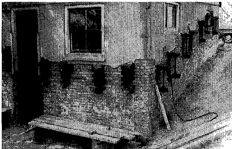
Volgemetselde muurgedeelten tussen de omhooggedraaide vijzels
